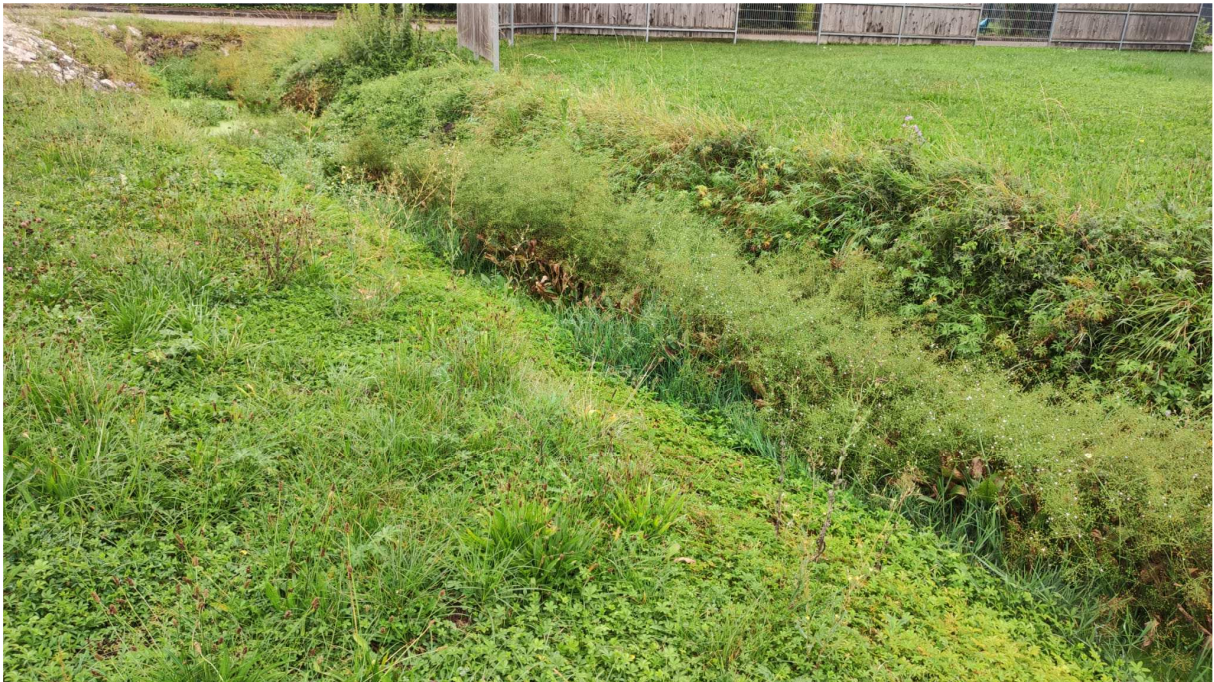
Abbildung 1: Graben ab der Fessenheimer Straße auf den ersten 70 m, Pkt. 1
