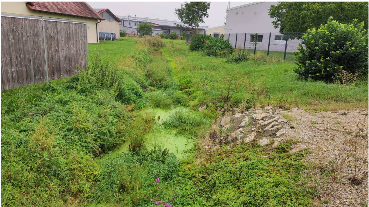
Abbildung 2: Graben ab der Fessenheimer Straße auf den ersten 70 m, Pkt.1
