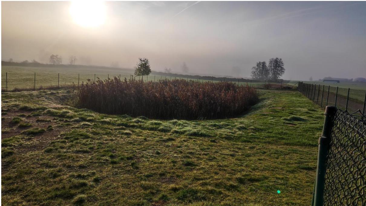
Abbildung 11: Retentionsbodenfilter bei EZG 2
