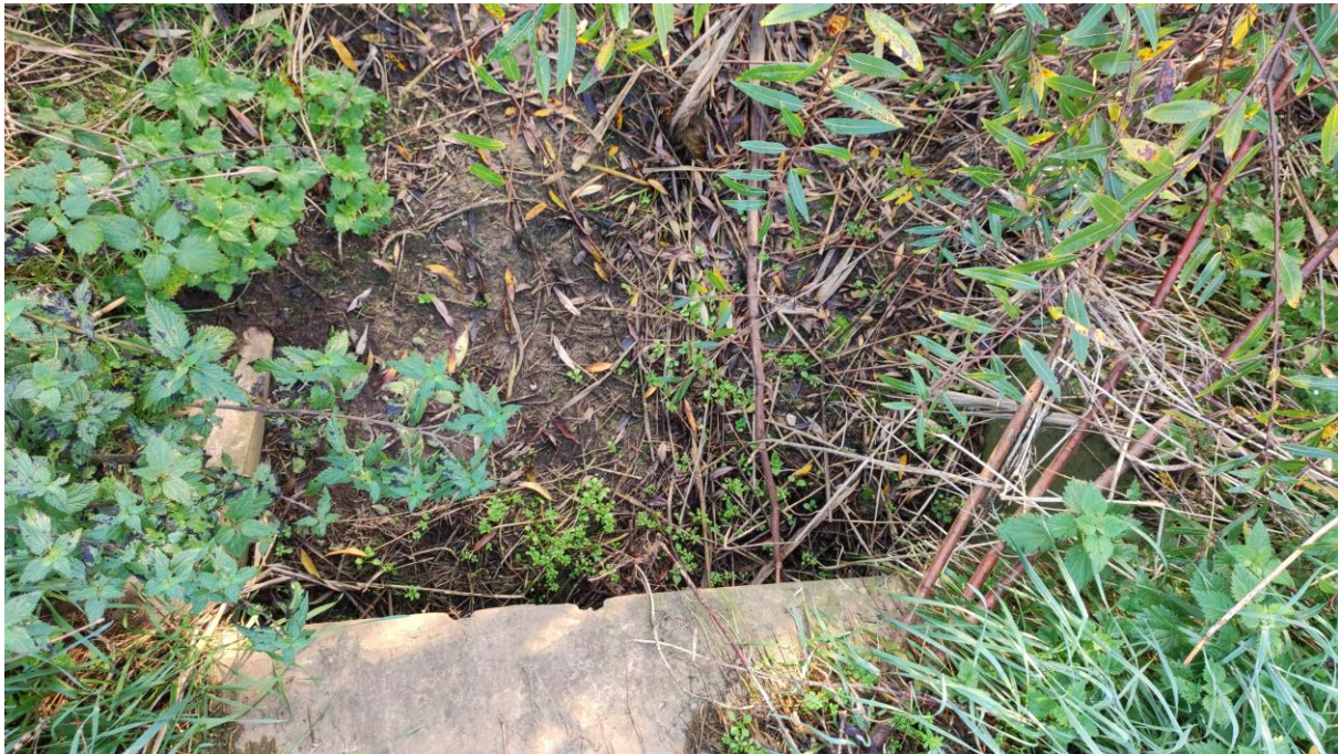
Abbildung 10: Auslauf aus EZG 1 in das Regenrückhaltebecken
