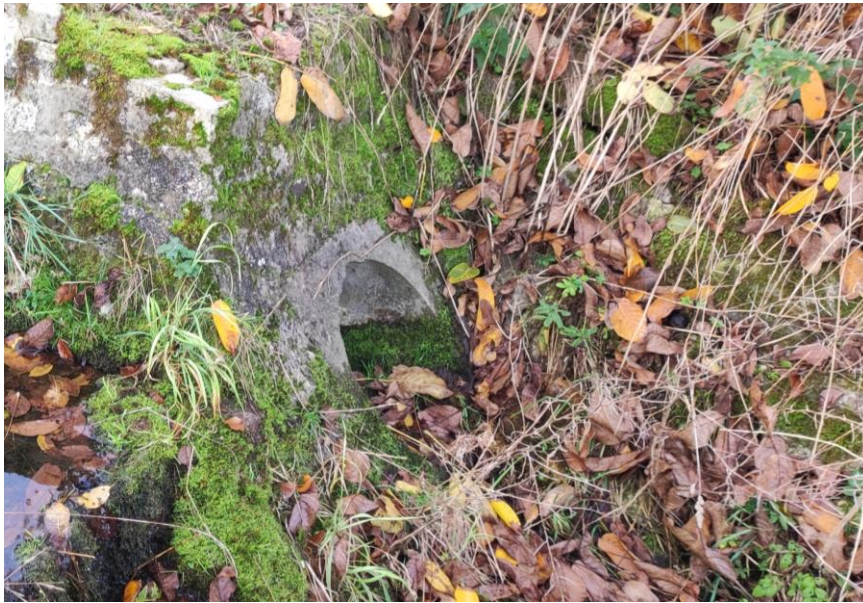
Abbildung 13: Auslauf aus EZG 1 in den Gemeindewiesgraben
