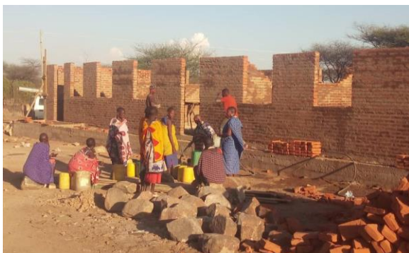
Bauarbeiten während Phase 1
