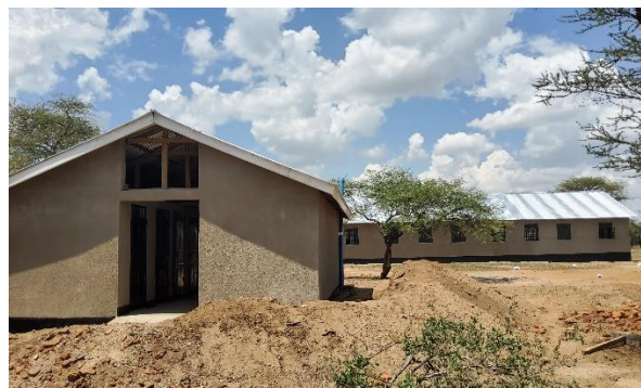
Phase 1 kurz vor Abschluss
